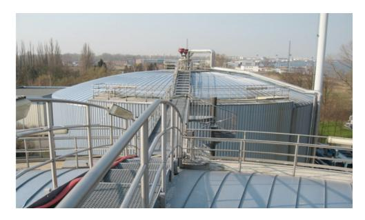
WWTP 2 Digester Biogas 80.000 m³/d 2 x 5000 m³ Volume 8300 m³/day 2 Cogen-Units Benchmark
